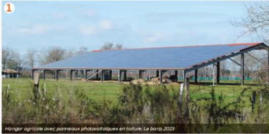
1 Hangar agricole avec panneaux photovoltaïques en toiture, Le barp, 2023
