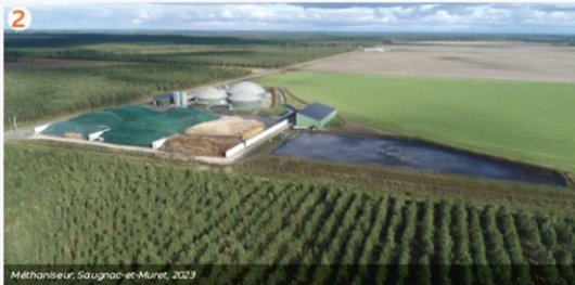
2 Méthaniseur, Saugnac et Muret, 2023
