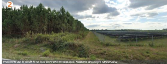
Proximité de la forêt face aux parcs photovoltaïques, Hostens © Google StreetView
