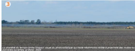
La plénitude du terrain limite l'impact visuel du photovoltaïque qui reste néanmoins visible à proximité des routes ou de parcelles ouvertes, Le Barp, 2023
