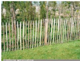
Les clôtures seront de type "girondine" composées d'échalas en châtaignier fendus disposés verticalement et fixés à des poteaux en bois massif, conformément au plan de composition (pièce PA4) ; leur hauteur ne devra pas dépasser 1,50 m, les portillons ou portails étant réalisés en bois assortis à la clôture et de même hauteur.
