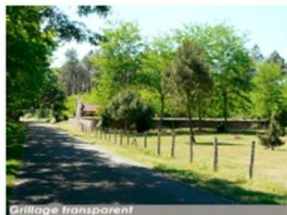
Les clôtures seront traitées, soit en grillage fixé sur des poteaux en bois, l'ensemble d'une hauteur maximum de 1,50 m, soit en clôture dite "girondine" composée d'échalas en châtaignier fendus disposés verticalement et fixés à des poteaux en bois massif, conformément au plan de composition (pièce PA4) ; leur hauteur ne devra pas dépasser 1,50 m.
