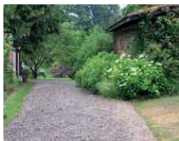
A Sorbets, des arbustes en pied de mur
