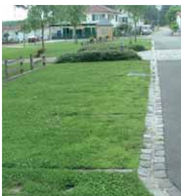
Lesgor. Un stationnement en dalles de gazon alvéolées avec arrosage intégré pour un stationnement occasionnel
