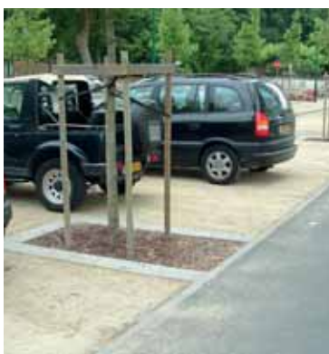
Labenne. Un stationnement en stabilisé renforcé
