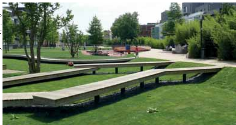
Un espace public servant de bassin d'infiltration
