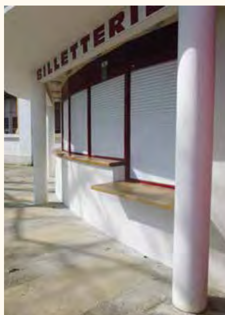
Dax, billetterie accessible
