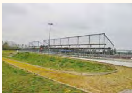
Rampe d'accès intégrée dans l'aménagement extérieur
