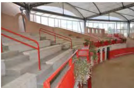
Gamarde Couverture des arènes, architecte ARCAD
