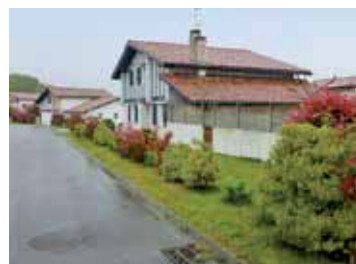
A Bidart et Arbonne, une bande de 5 mètres d'espace vert, non clôturée, est aménagée entre la rue et l'espace privé
