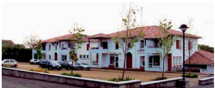
A Saint-André-de-Seignanx, des activités et des services en rez-de-chaussée (boulangerie, coiffeur, banque, restaurants...) s'associent à de petits appartements aux étages.
