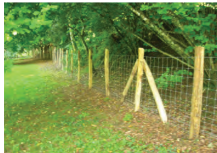
Clôture type ursus de 1,2m avec piquets bois éclatés (section carrée)
