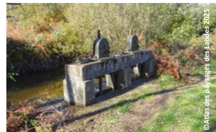
▲ Des ouvrages ponctuent le site et participent à la gestion de l'eau
