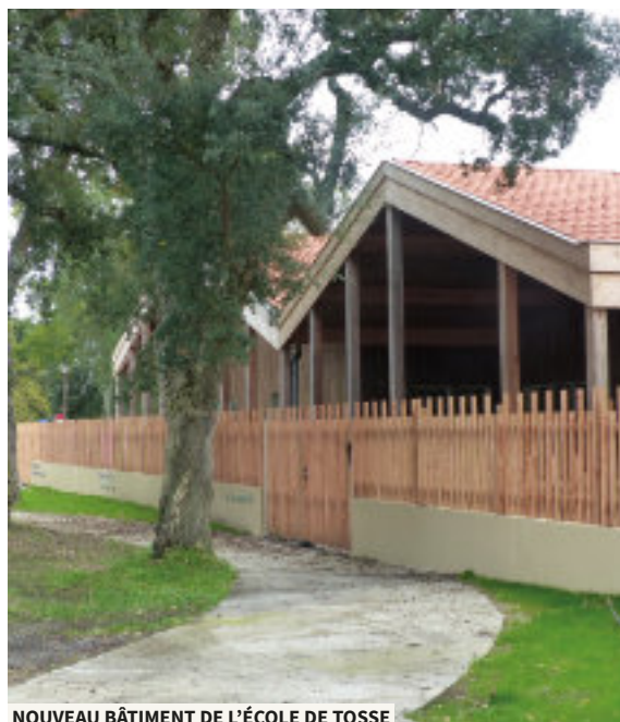
NOUVEAU BÂTIMENT DE L'ÉCOLE DE TOSSE
